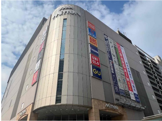
ノジマの運営する大規模商業施設『MitteN』 京王線府中駅南口より徒歩1分 公式ホームページURL https://mitten-foris.jp/
